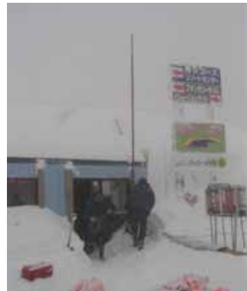
無線中継基地の状況
